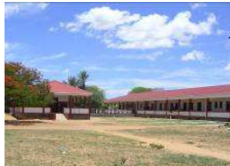
Chiulo Hospital Ombadja, Angola
